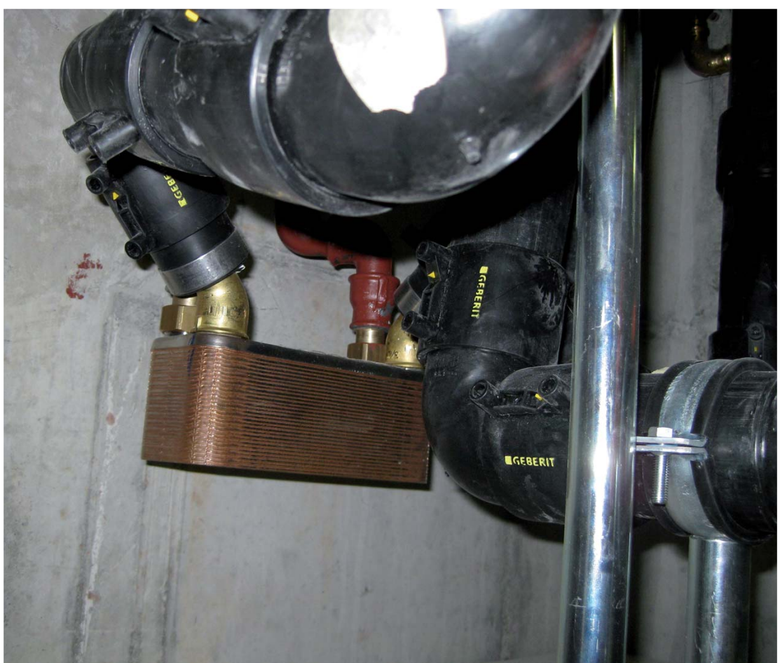
In diese Verteilung wird neben einem Plattentaucher auch noch ein Grandertauscher eingebaut. Als Pumpe dient eine KSB 6 Pumpe mit ca. 600 W. Bei dieser Anlage wird das Wasser in der Regeneration angesogen und über den Quellstein wieder eingeführt.
