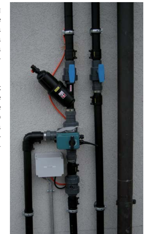
Die Dreiwegventile können auch außen an der Hauswand montiert werden. Ist das Dach zu hoch, wird anstelle des Dreiwegventils eine Pumpe eingesetzt. Diese muss aber auf der Höhe des Wasserspiegels zu liegen kommen.
