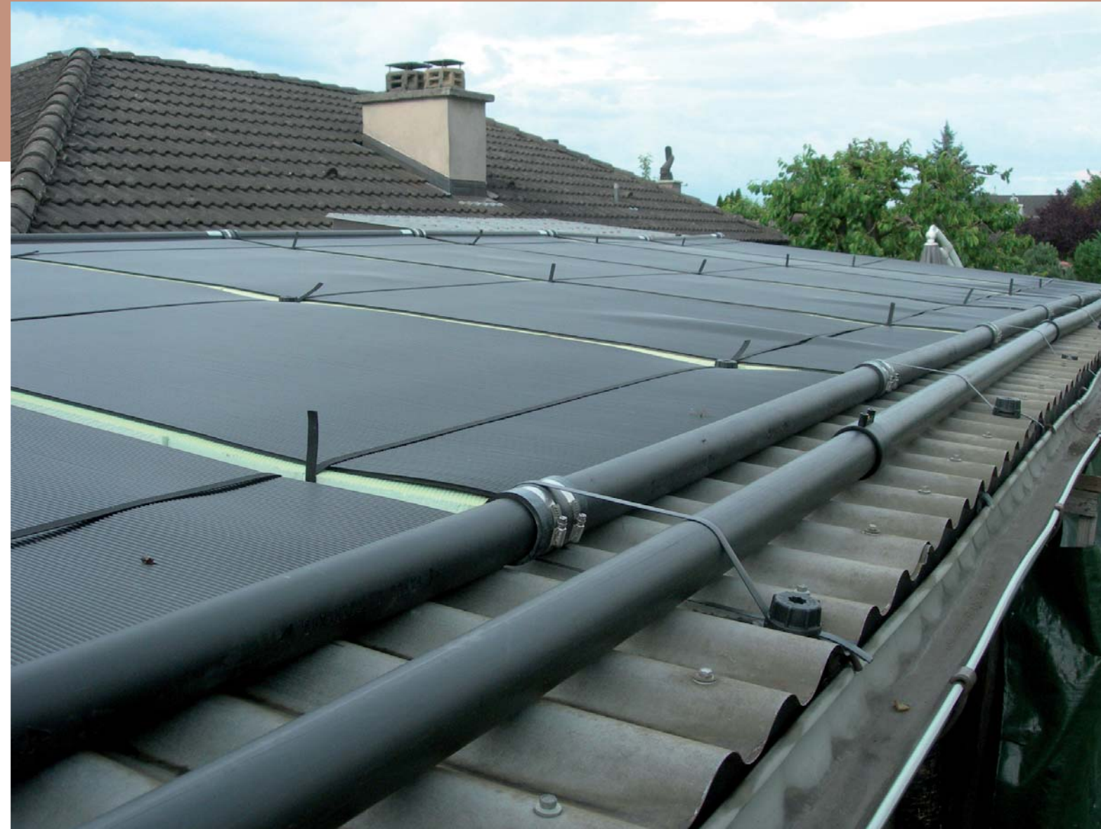
Solarabsorber – sie sind sehr dünn, was sie zugleich auch sehr effizient macht. Sie können praktisch auf jedem Dach montiert werden.
