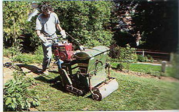
Abb. 8 Walzen des Fertiggrasens
