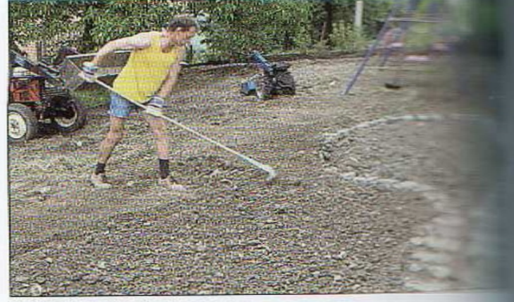
Abb. 4 Vorbereitung der Rasenfläche zum Verlegen
