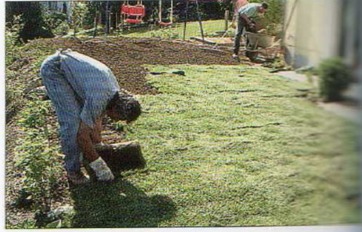
Abb. 6 Verlegen des Rollrasens (2)
