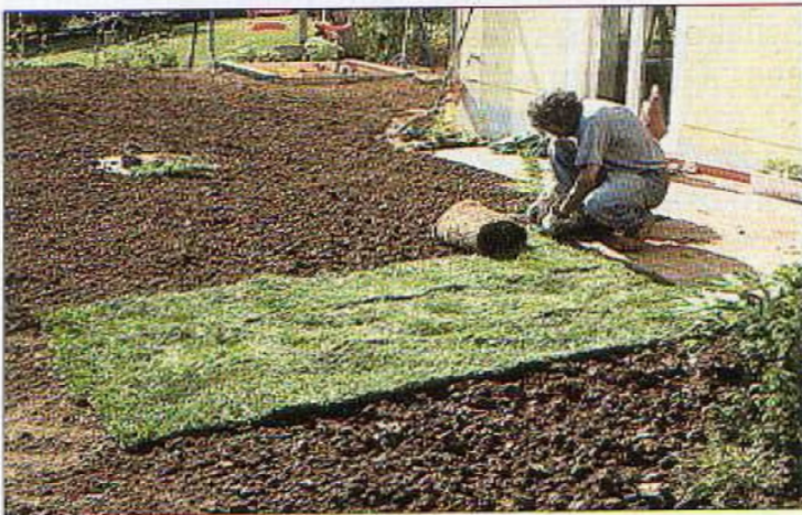
Abb. 5 Verlegen des Rollrasens (1)
